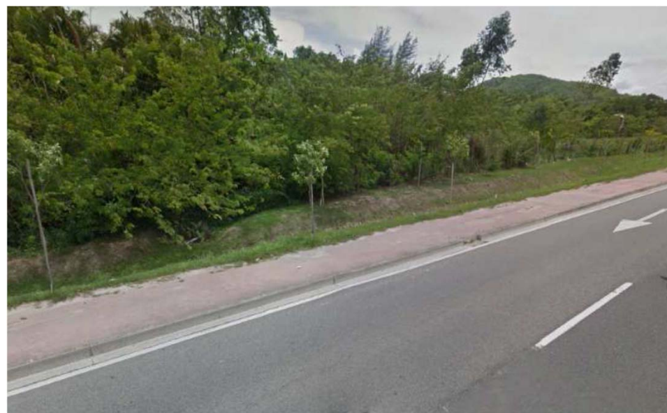
Figura 196 - Exemplo de pavimento desgastado, com falhas e desníveis na ciclovia da Avenida das Américas 1
