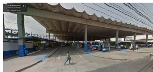
Figura 96 - Terminal Nova Iguaçu
