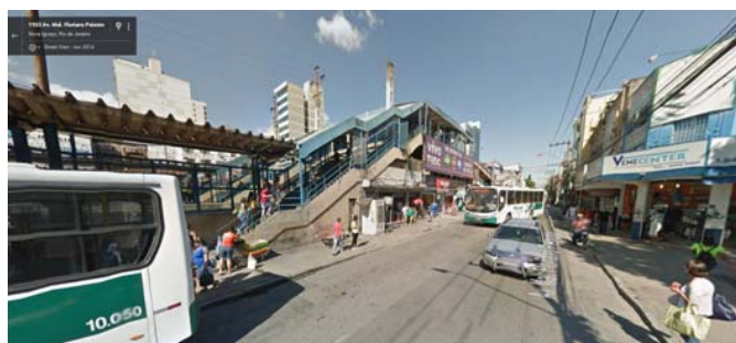
Figura 90 - Estação Nova Iguaçu
