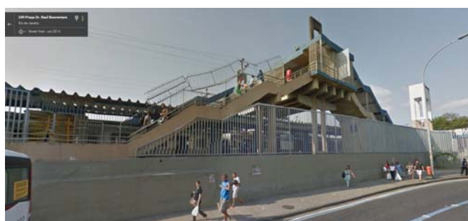
Figura 89 - Estação Campo Grande
