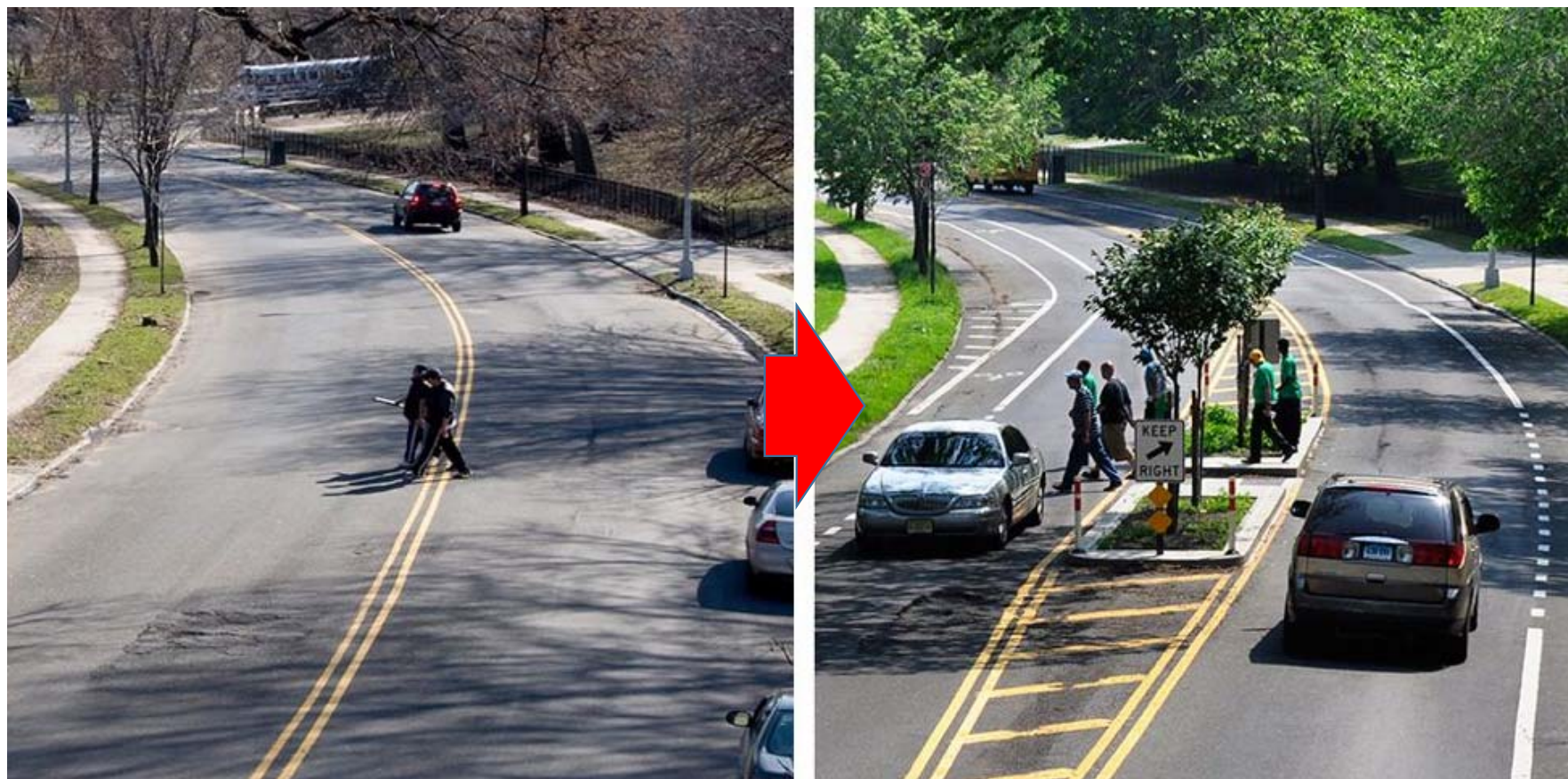
Figura 217 - Exemplo de inserção de canteiro central adequado para a travessia dos pedestres
