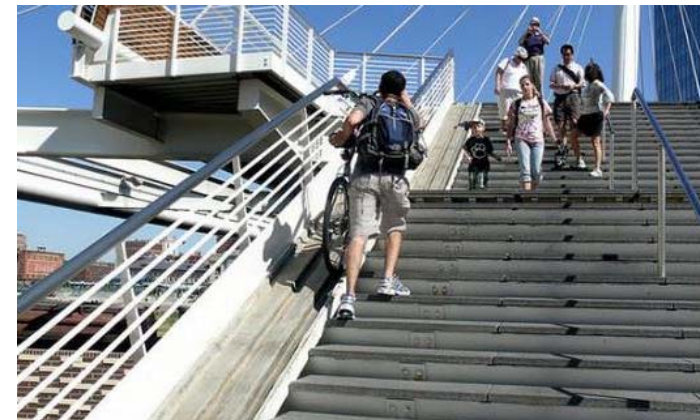
Figura 207 - Canaleta em concreto 1
