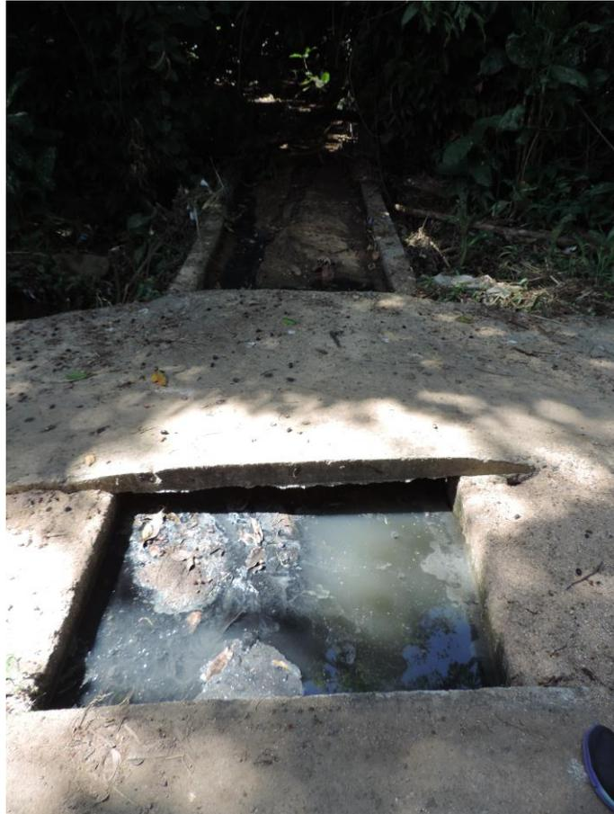
Figura 30 – Foto da parte alta do braço sul do Rio Cantagalo (Campo Grande) no Centro Ecológico Ana Gonzaga, após passar pela Favela Caminho do Morro, mostrando canalização do rio com assoreamento e lançamento de esgoto. Foto de Vladimir da Franca Fernandes.
