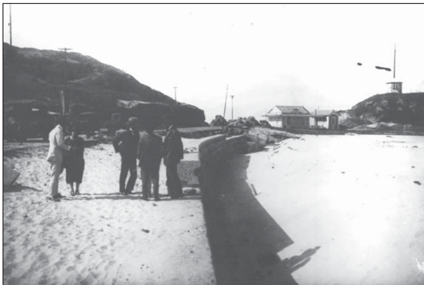
Obras na orla do Arpoador – Ao fundo se veem as construções que foram demolidas. Augusto Malta – 1924 (AGCRJ)
