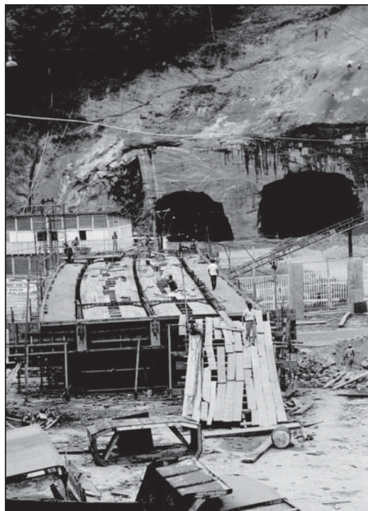
Abertura do túnel Rebouças. 1965/1970, s.a., – AGCRJ
