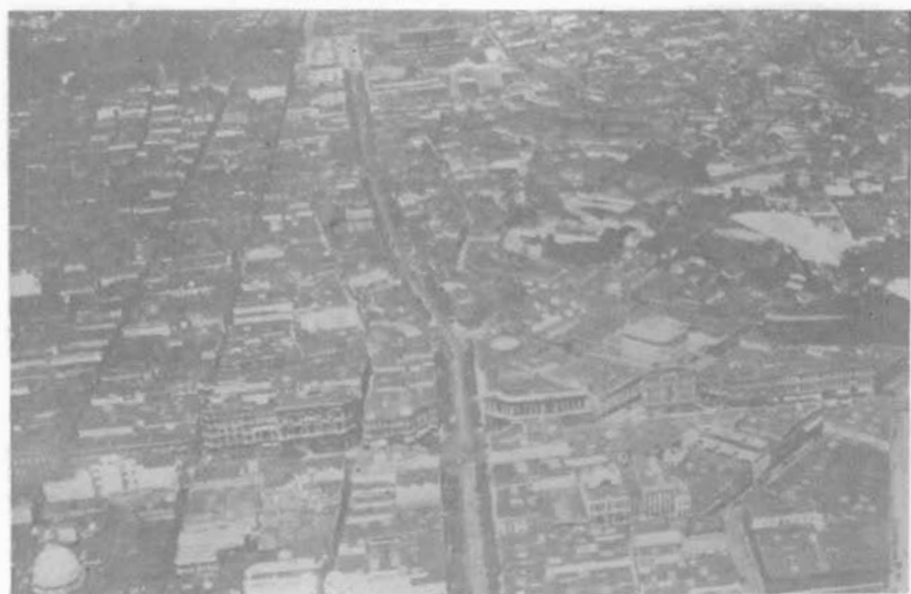
35. Vista Aérea do Centro, observando-se o cruzamento da Avenida Rio Branco com o eixo Visconde de Inhaúma-Marechal Floriano, a mais importante artéria de ligação com as Zonas Norte e Suburbana até a abertura da Avenida Presidente Vargas, na década de 1940. MIS
