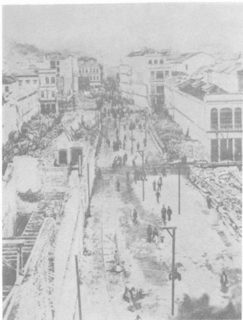
28. As demolições para a abertura da Avenida Central, entre as ruas General Câmara e Santa Luzia
