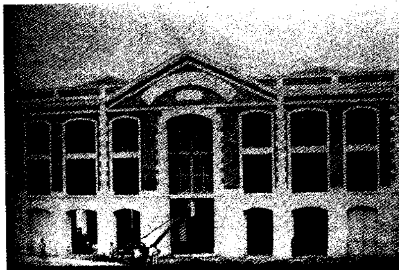
11. Um dos armazéns da Cia. Docas de D. Pedro II, fundada por André Rebouças, servido por guindaste manual. Foto Juan Gutierrez, 1886/1890. MHIN
