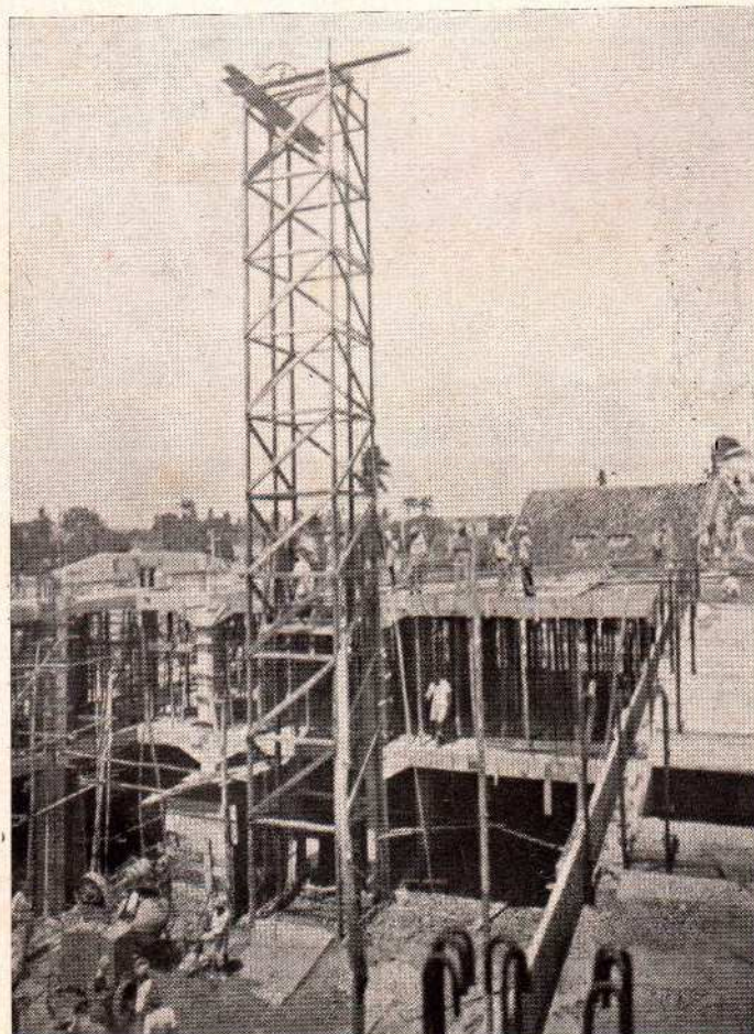
Hospital da Brigada Militar — Aspecto da construção
