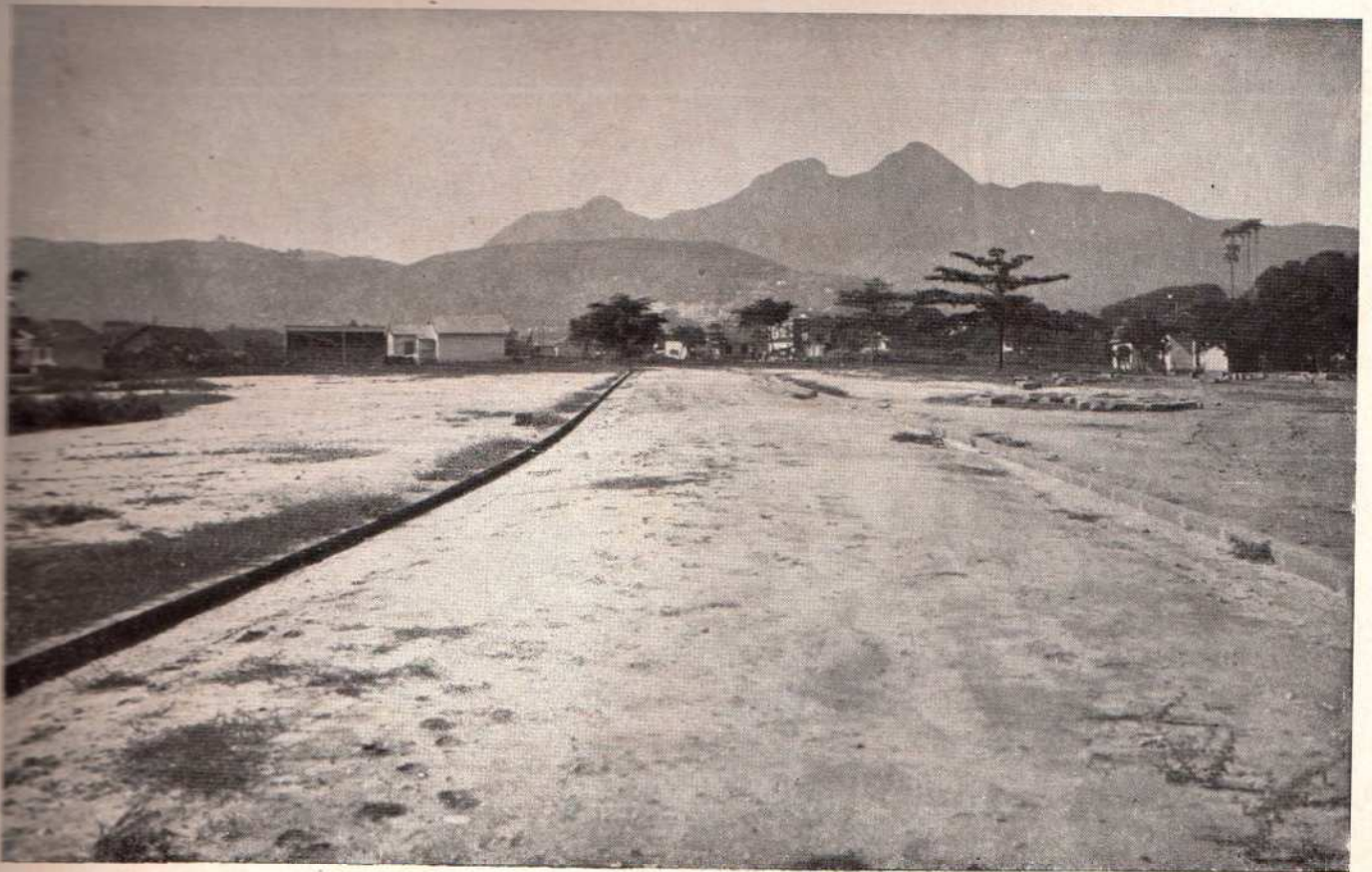
Obras de construção da RUA BRAULIO CORDEIRO — JACARÉ
