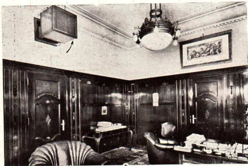
Um escriptorio com installação de Ar Condicionado. A seta indica a collocação do Climatizador.
