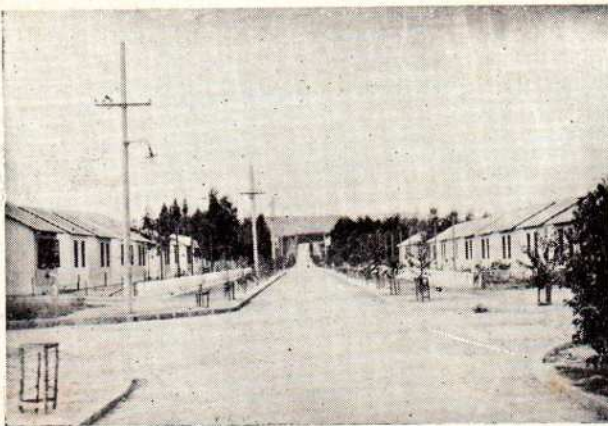
Aspecto de uma rua com canalização de aguas pluvias, arborização, calçamento e iluminação publica
