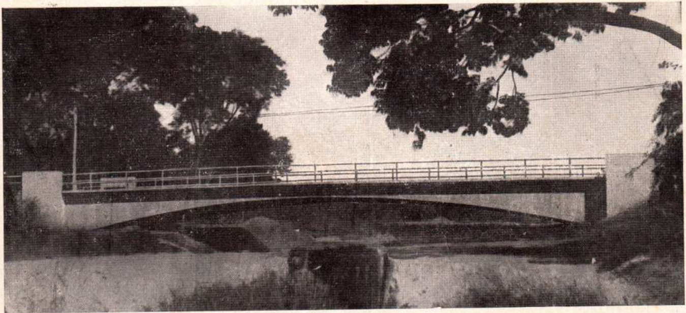
Ponte sobre o rio Cabuçu — (Projecto e construção do O 2 E T)
