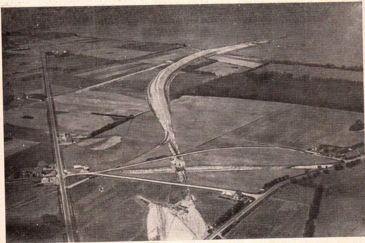
Fig. 20 — Vista aerea do movimento de terra em Falster
