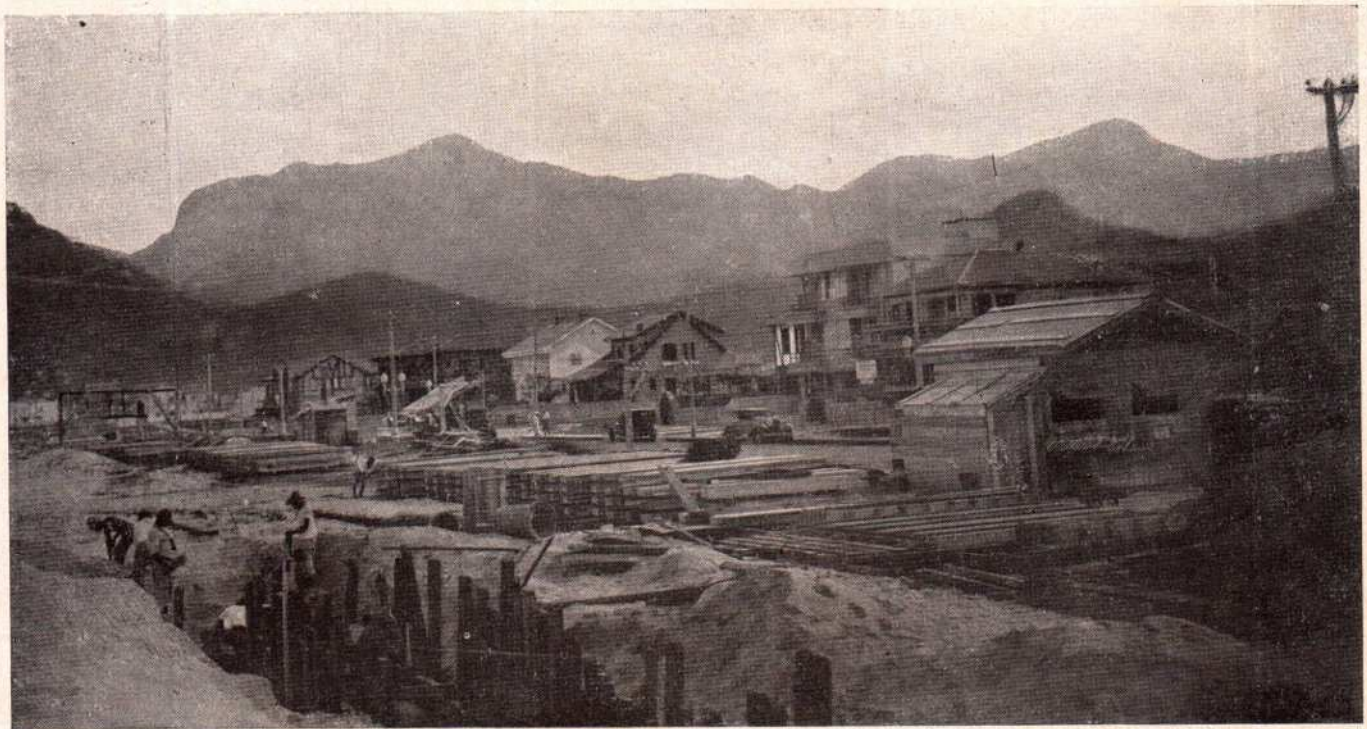
Phase da fabricação das estacas
