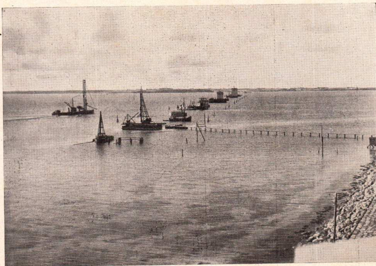
Fig. 13 — A ponte de Storstrom vista de Masnedoe. A' frente se vêem dois pilares em construção no interior de uma enseccadeira commum de estacas pranchas de aço
