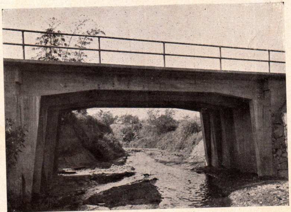
Outra vista da ponte na Rua Picuhy
