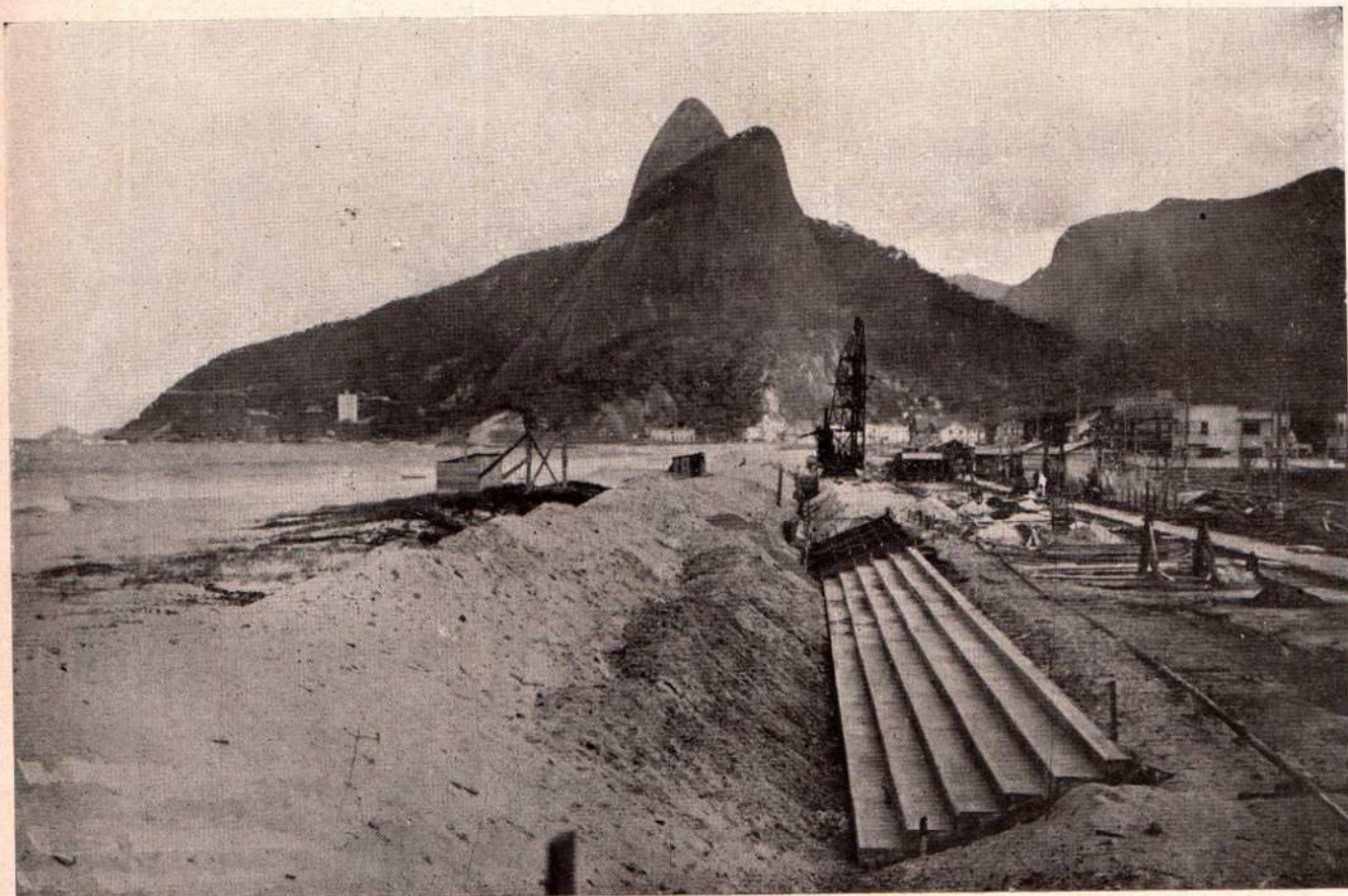
Trecho do coroamento já concluido
