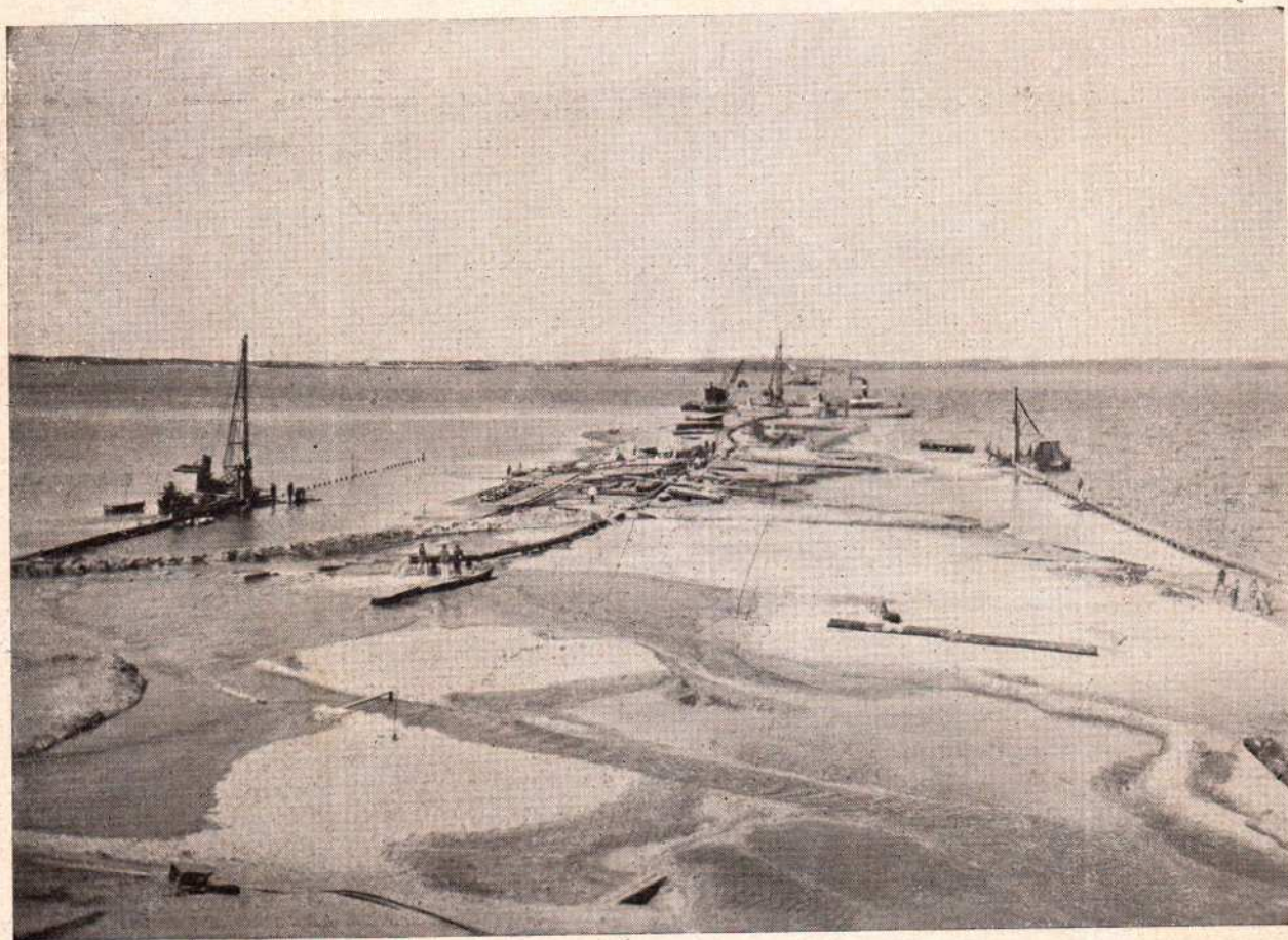
Fig. 21 — Aterro em construção no Storstrom. Até a cota + 4,00 ms. o aterro é executado com areia recalçada por meio de bombas entre duas paredes de pranchões de madeira. Ao lado vê-se um bate-estacas e ao fundo uma excavadeira fluctuante no encontro em Falster
