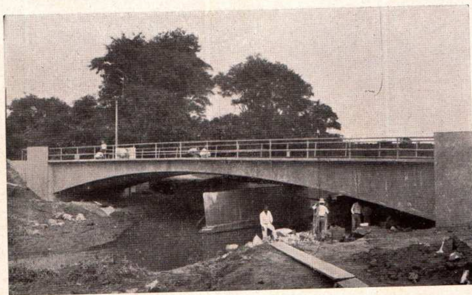
Outra vista da ponte sobre o rio Cabuçú
