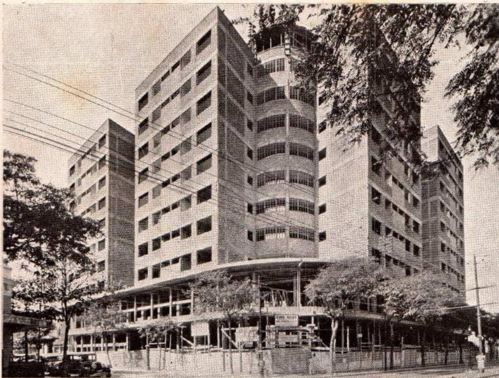
Fig. 2 — Fachada principal do Edifício, vista da rua Copacabana.
