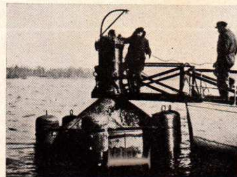
Fig. 6 — Leitura dos registros feitos depois da caldeira voltar á tona.
