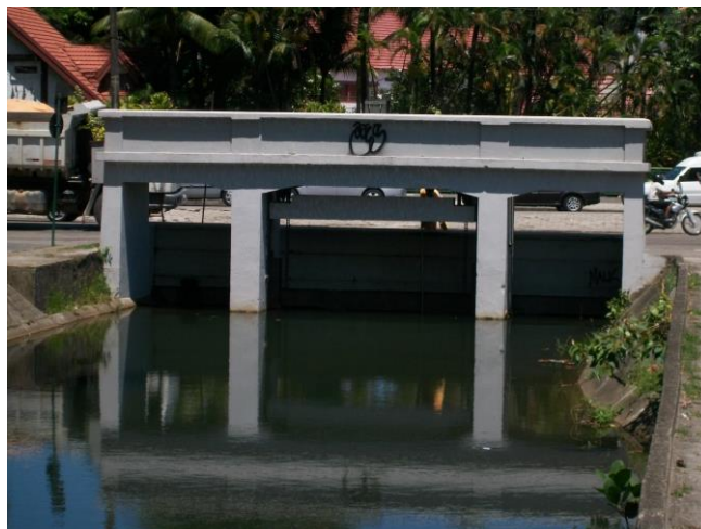
Figura 7.12- Comporta – Rua General Garzon
