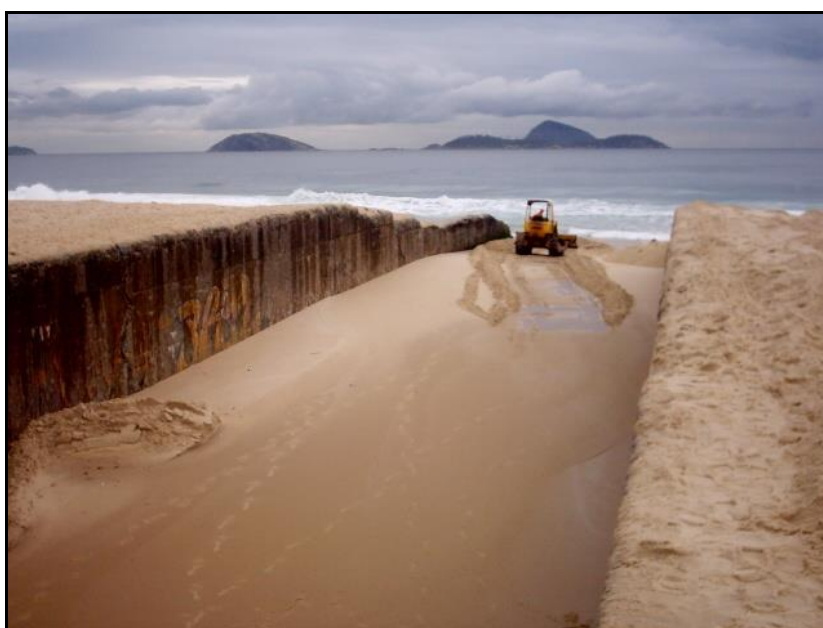
Figura 3.5 – Retirada de areia do canal do Jardim de Alah.
