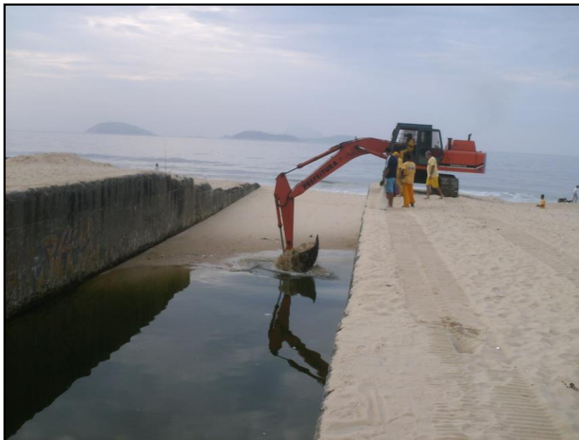
Figura 3.4 - Máquinas desobstruindo o canal do Jardim de Alah.
