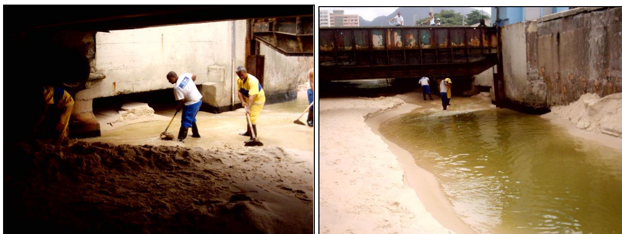
Figuras 6.6 - Desobstrução manual do canal do Jardim de Alah (fev/2010)
