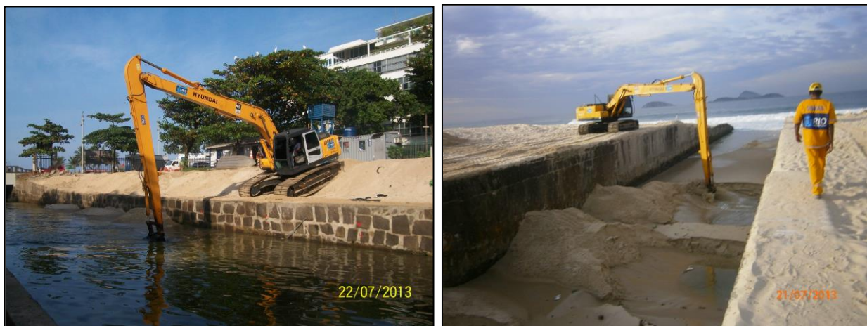
Figuras 6.5- Desassoreamento do canal do Jardim de Alah com escavadeira hidráulica (jul/2013)
