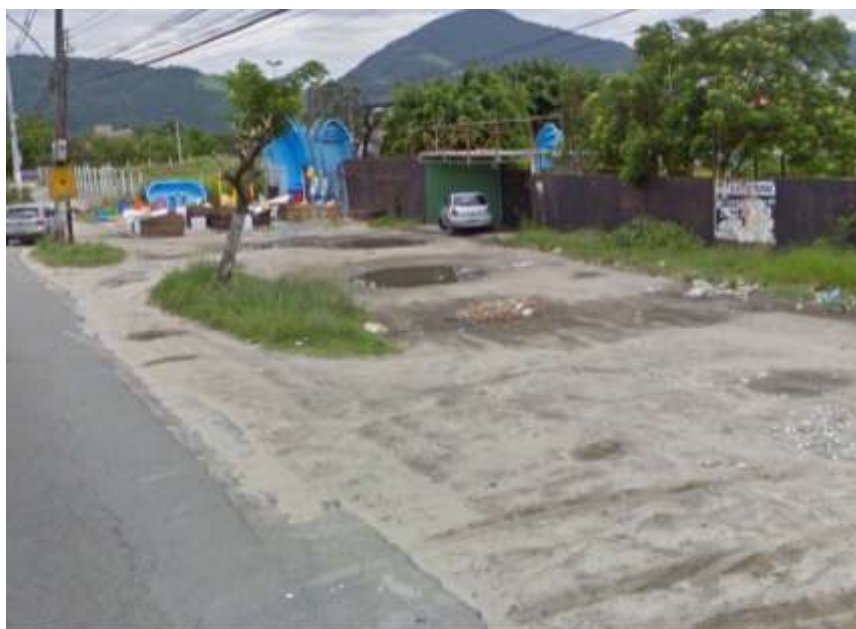
Figura 9.52 – Vista da margem da Av das Américas km 20,5 (Notre Dame)
