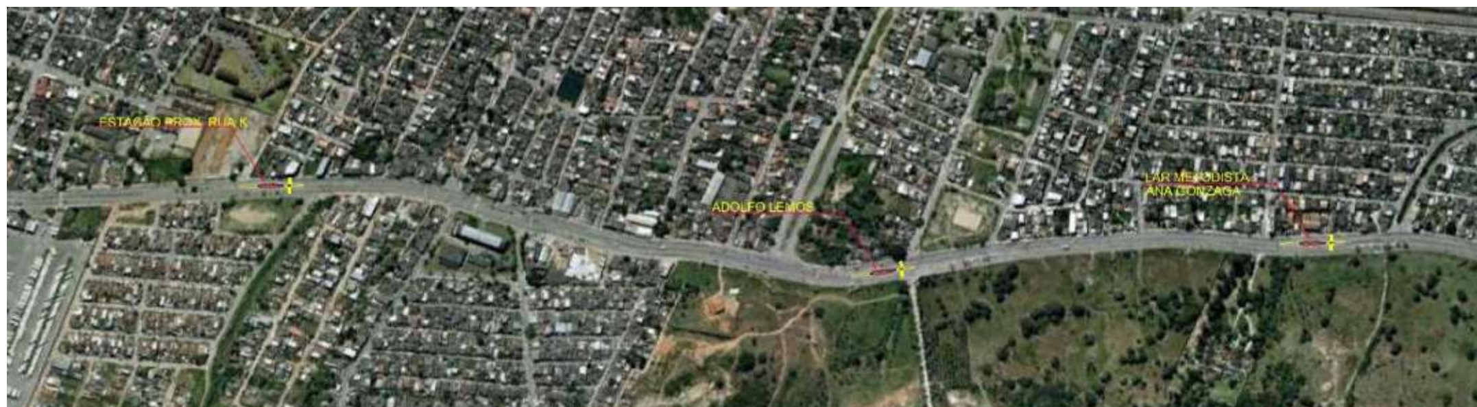
Figura 8.24 – Trecho Cesário de Melo (estação Rua K à estação Lar Metodista Ana Gonzaga)
