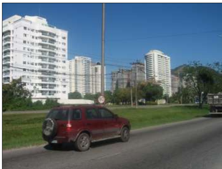
Figura 9.49 – Vista do local onde será implantada a estação Guiomar Novais. Estação Expressa Recreio km 19
