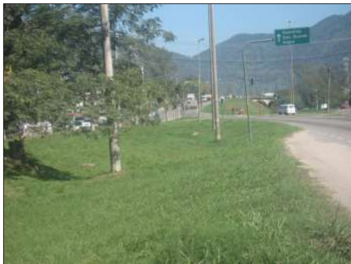
Figura 9.51 – Vista do local onde será implantada a estação Recreio km 19, a última estação no trecho duplicado da Av das Américas.
