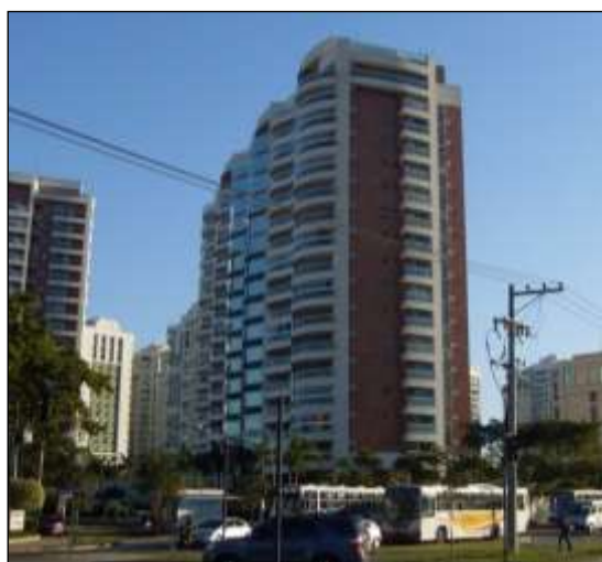
Figura 9.25 – Vista do canteiro central onde será implantada a estação Barra Mall.
