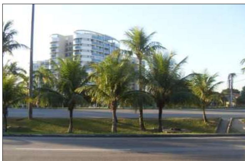
Figura 9.27 – Vista do canteiro central onde será implantada a estação Santa Mônica.
