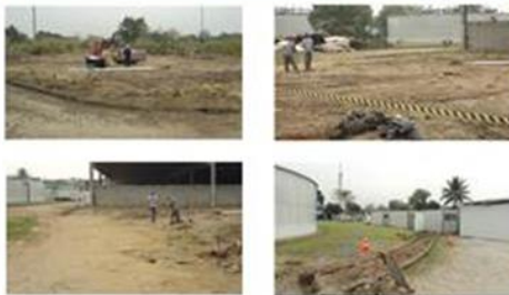
Implantação de rede na Rua Osman Lins
