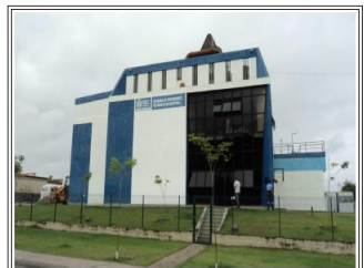
Vista geral da ETE Sepetiba
