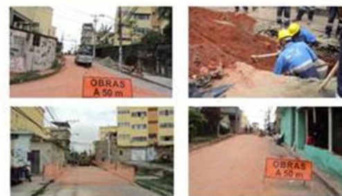
Implantação de rede no Beco da Jaqueira
