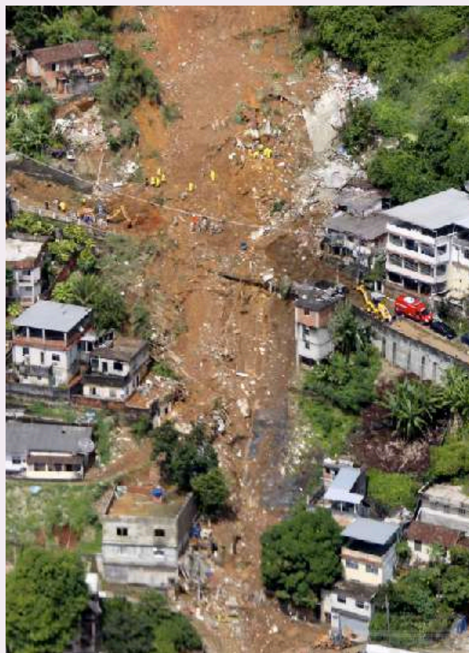
Escorregamento planar de solo em encosta no Morro dos Prazeres, Abril de 2010. Fonte: Geo-Rio
