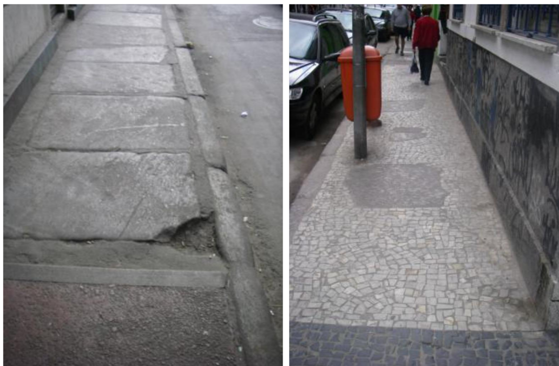
Figura 49 – Pedra costaneira. Rua Bento Lisboa, no Catete. Fonte: PCRJ/ IRPH, 2012.
