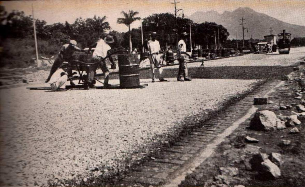
Pavimentação com BITUMULS executada pela Prefeitura, 29 D. V.
