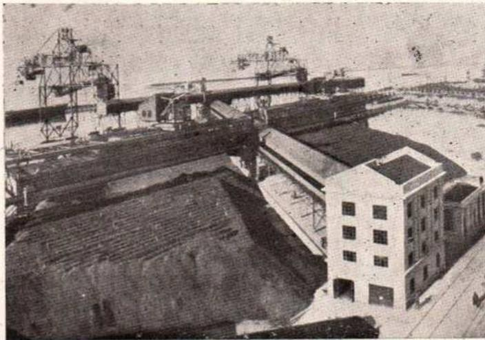
Veem-se em segundo plano as duas ruas de desembarque, veem-se tambem as duas pontes rolantes com capacidade de 300 ton./hora, que distribuem o carvão sobre a superficie util de cada deposito (7000 m2.).
