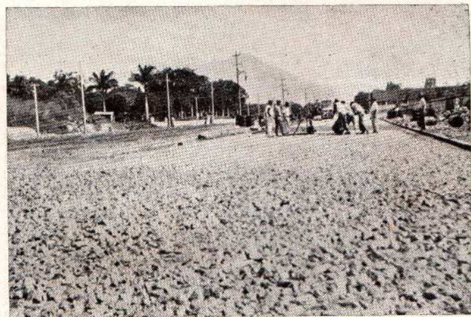
Turma da 29 D. V. no serviço de pavimentação a Bitumuls da Av. Duque de Caxias — Rio de Janeiro.
