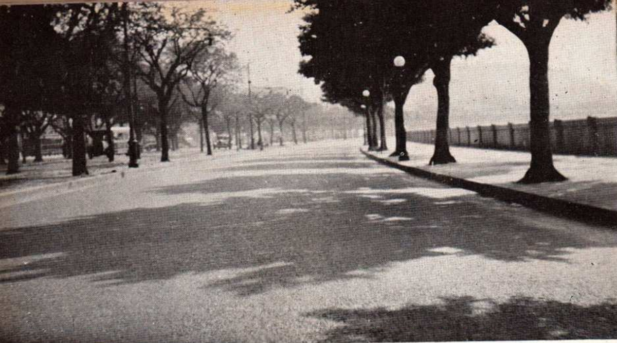
Trecho da Av. Beira-Mar na Praia de Botafogo — Rio de Janeiro. A camada de pedra está preparada para receber o tratamento com Bitumuls. Esta pavimentação, feita em Maio de 1933, tem resistido em magníficas condições, o mais pesado e intenso tráfego da cidade, cerca de 10.000 veículos por dia.
