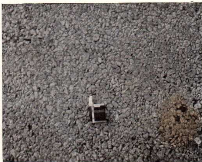
Em condições de receber Bitumens. Note-se o perfeito fechamento de vãos da camada de pedra prompta.
