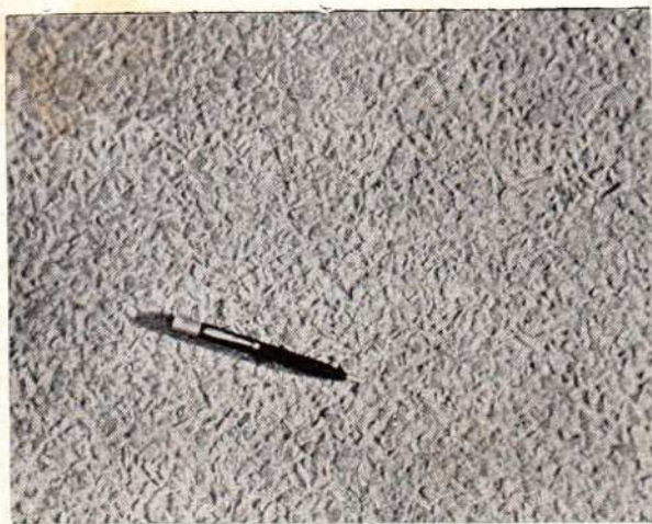
Textura typica das pavimentações com Bitumens. Absolutamente impermeavel, apesar de expor as arestas das pedras fortemente ligadas, offerecendo, uma superficie anti-derrapante. Não ha excesso de asfalto.
