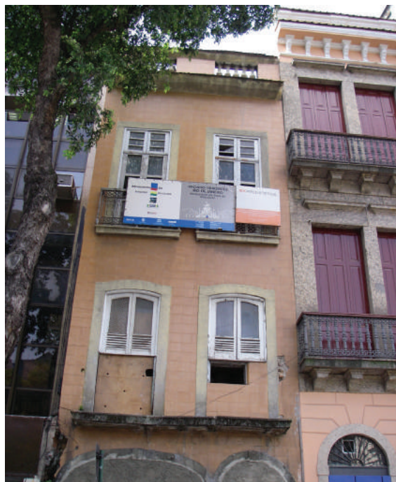
Centro Carioca de Design antes da recuperação (2007)
