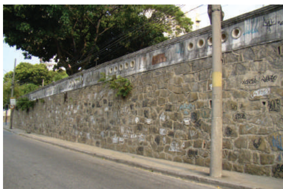
Muro de Arrimo e demais elementos do conjunto urbano entre a Rua Santos Titara, esquina com Rua Almirante Calheiros da Graça, e a Avenida Amaro Cavalcanti – Todos os Santos
