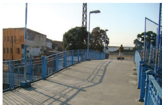
Passarela de acesso à Estação Riachuelo
