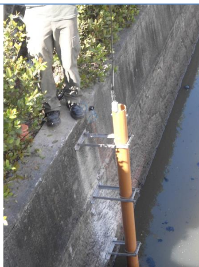
Instalação do sensor de nível
