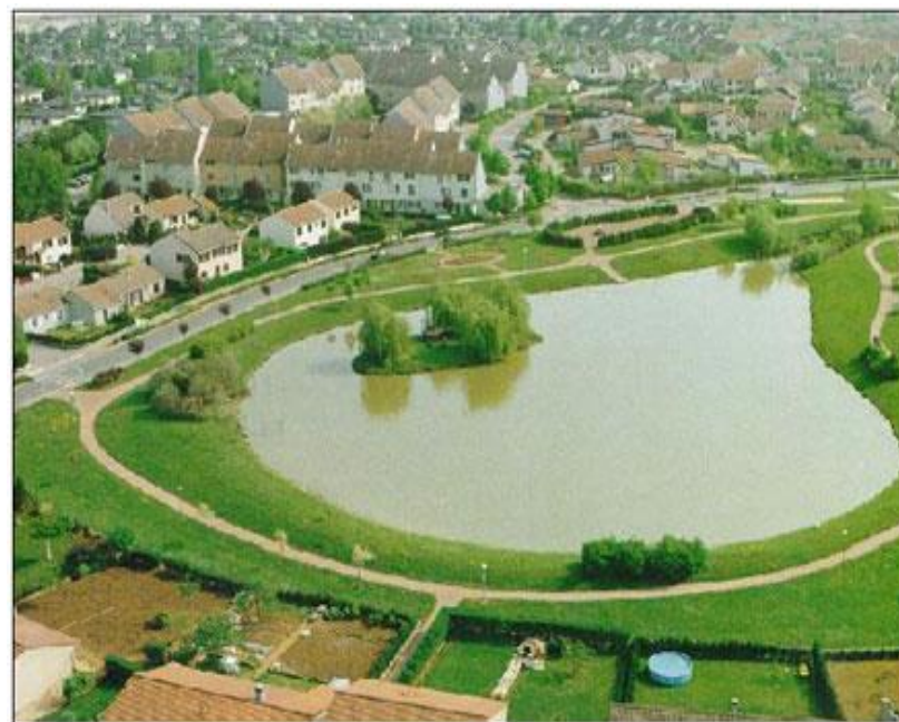
Figura 7-3 – Bacia de retenção.
