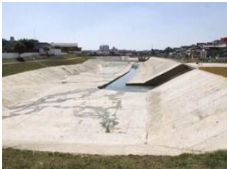
Figura 7-2 – Bacia de retenção.
