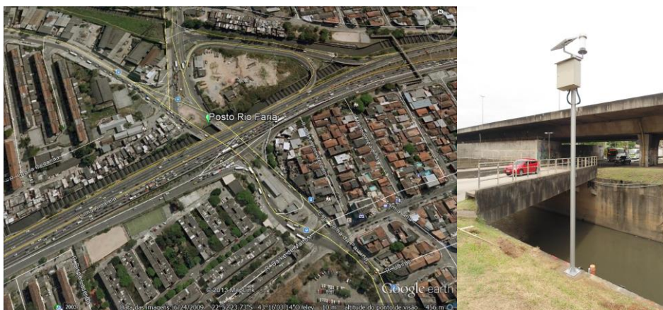
Figura 8-23 – Estação telemétrica – Lat.: 22° 52' 22,07" S Long.: 043° 16' 4,18" W
