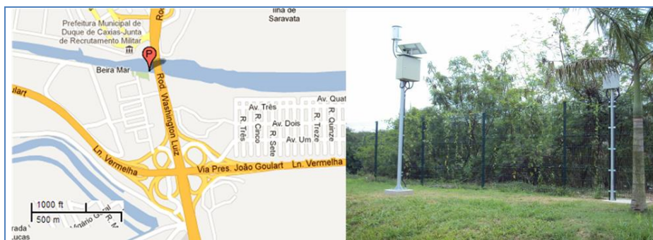
Figura 8-9 – Estação telemétrica – Lat.: 22°18'10.39"S – Long.: 43°17'26.51"W.
