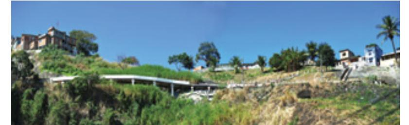
Fig. 34 Rua da Grota, Morro da Providência. Neste caso a intervenção proposta considerou a execução de obras de viaduto para transformar o beco em via carroçável local, em nível, melhorando sensivelmente a acessibilidade e permitindo a circulação do microtrator de coleta de lixo, com isso evitando o despejo irregular encosta abaixo. | Fonte: Fabio Costa, SMH.
