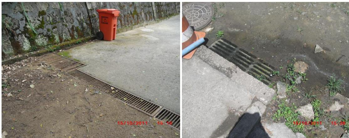
**Figura 5.65** Vista de canaletas de drenagem de águas pluviais na área de uso público do Parque (à esquerda) e bueiro para captação de águas pluviais na proximidade da sede administrativa do Parque (à direita). Fonte: Detzel Consulting, 2011.
