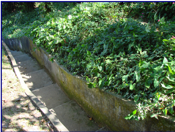
Figura 11 – Calha de drenagem construída na época da implantação do antigo Parque da Catacumba.
