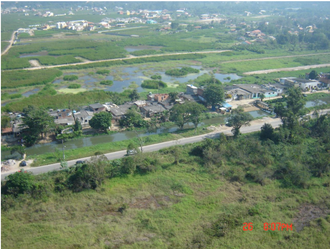
Figura 21 – Aspecto das áreas de brejo sendo ocupadas no Bairro de Vargem grande, baixada de Jacarepaguá.
