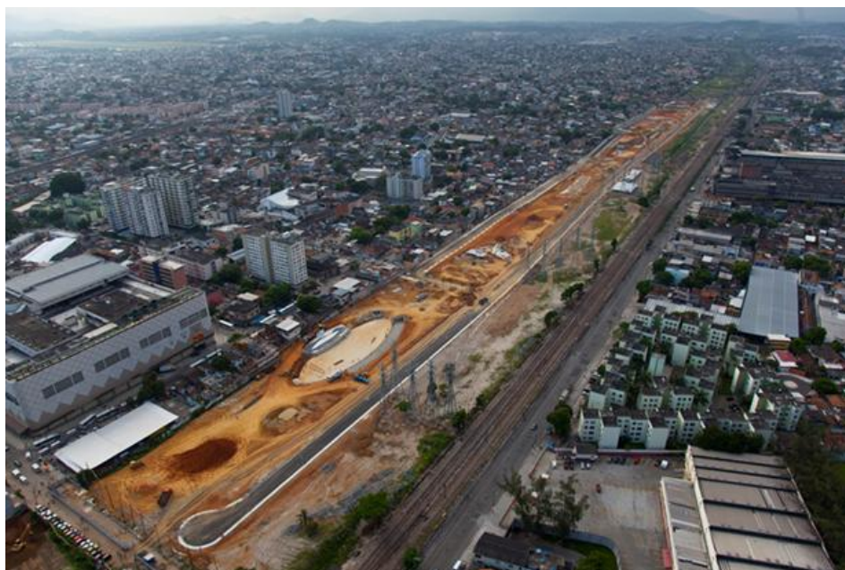
Figura 9 - Parque urbano sendo construído em Madureira
