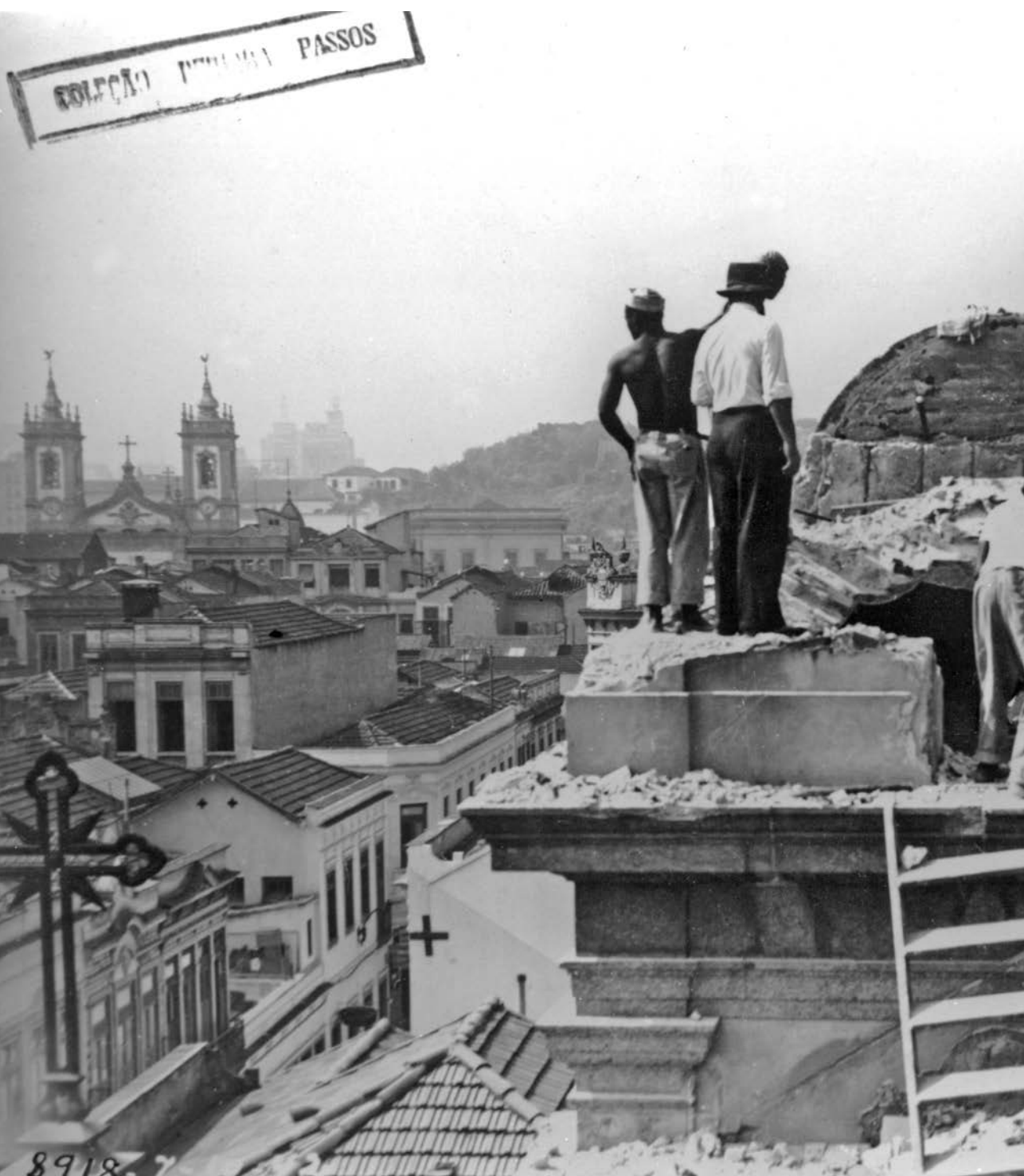
Figura 05 - Demolição da Igreja Nossa Senhora da Conceição. Uma das igrejas atingidas pela fúria demolidora. Fonte: AGCRJ, Demolição (Provável Uriel Malta), 1942.
