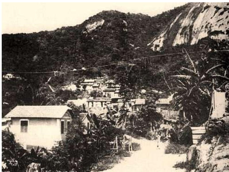
Figura 1 – Fotografia do núcleo de moradias da Rocinha.
