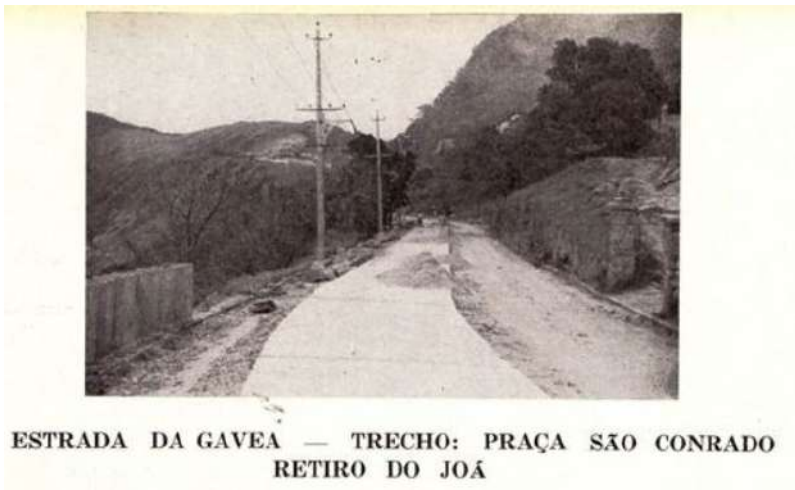
Figura 16 – Fotografia das obras de pavimentação da Estrada da Gávea.
