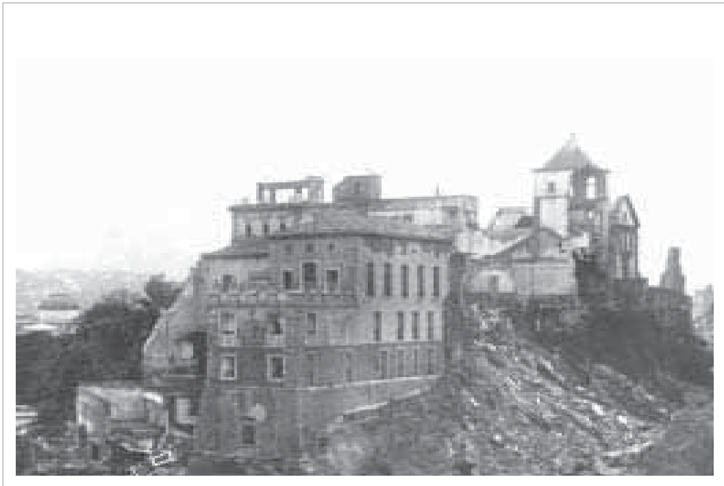
Destruição do antigo complexo jesuítico, nos últimos dias do governo Carlos Sampaio Foto Augusto Malta, 12/11/1922 FMIS/RJ
