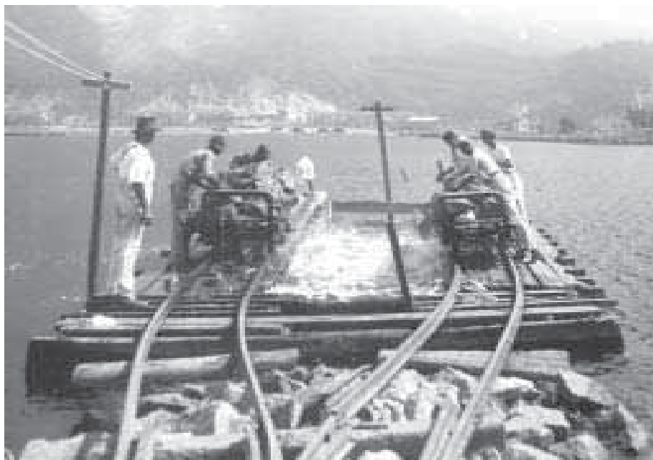
Obras de enrocamento na lagoa Rodrigo de Freitas Foto Augusto Malta, 23.2.1922 FMIS/RJ
