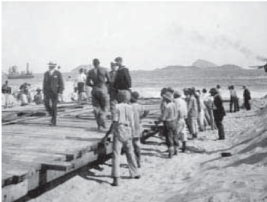
Chegada da draga à praia de Ipanema, para ser transportada até a lagoa Rodrigo de Freitas Foto Augusto Malta, 1922 FMIS/RJ
