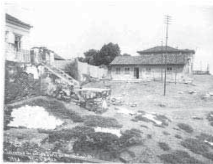
Casas construídas na antiga fortaleza de S. Sebastião, no morro do Castelo Foto Augusto Malta, 11/3/1922 FMIS/RJ
