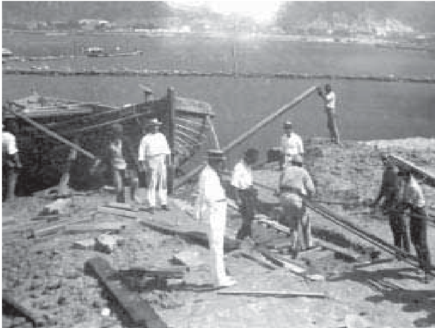
Obras na lagoa Rodrigo de Freitas Foto Augusto Malta, 1922 FMIS/RJ
