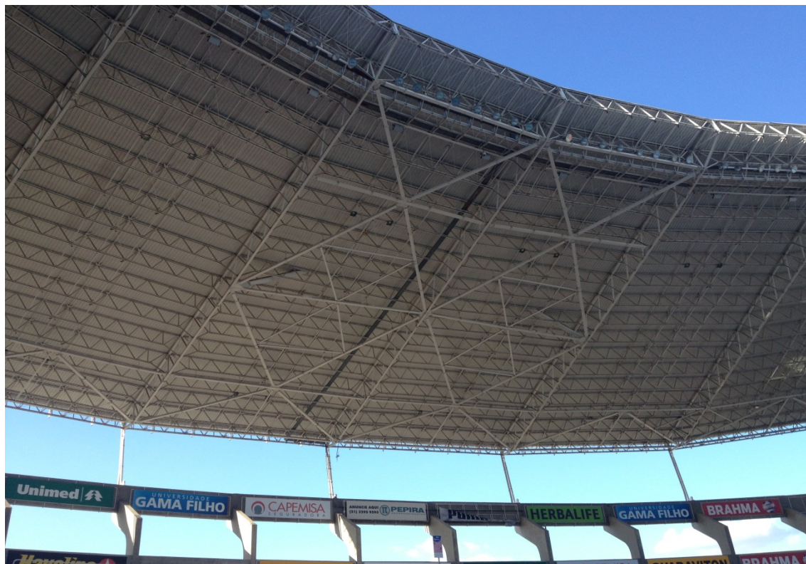
Foto 9 – Vista do sistema de travejamento horizontal mostrando a treliça do lado sul bem como o anel treliçado em toda a volta
