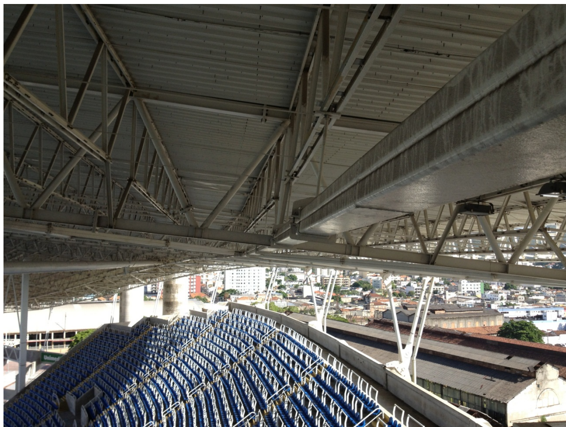
Foto 7 – Vista de uma tesoura travejada pelas terças
