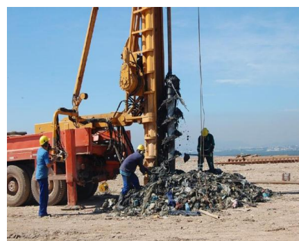
PERFURAÇÃO DE POÇO PARA CAPTAÇÃO DE BIOGÁS DO AMJG
