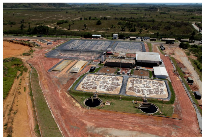
CTR-RIO – UNIDADE DE TRATAMENTO DE CHORUME (Fonte: COMLURB)
