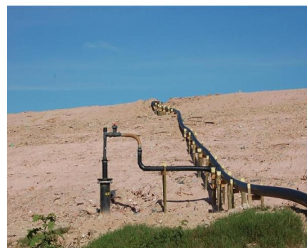
TRINCHO DA REDE DE CAPTAÇÃO DE BIOGÁS E VISTA DA INSTALAÇÃO DA REDE DE CAPTAÇÃO DE BIOGÁS NO AMJG (Fonte:COMLURB)
