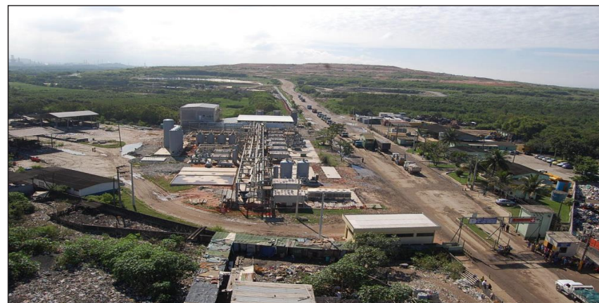
VISTA AÉREA DA UNIDADE DE PURIFICAÇÃO DO BIOGÁS DO AMJG (Fonte:COMLURB)
