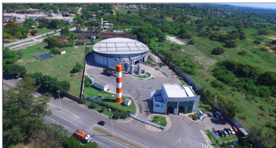
ESTAÇÃO DE TRANSFERÊNCIA DE SANTA CRUZ Fonte: COMLURB
