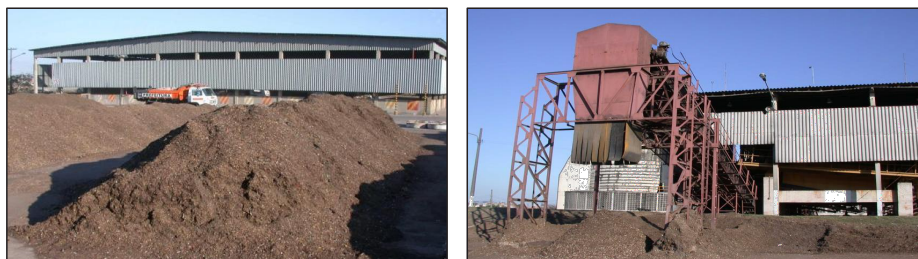
USINA DE COMPOSTAGEM DO CAJU – LEIRAS DE COMPOSTO CURADO E UNIDADE DE PENEIRAMENTO - Fonte: COMLURB
