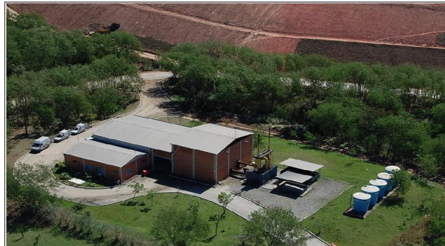
VISTA GERAL DO SISTEMA DE PIROLISE PARA TRATAMENTO DE RSS, NA ÁREA DO ATERRAMENTO DE GERIÇÃO
