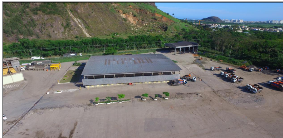
ESTAÇÃO DE TRANSFERÊNCIA DE JACAREPAGUÁ Fonte: COMLURB
