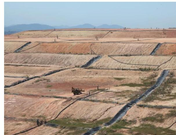
TRECHO DA REDE DE CAPTAÇÃO DE BIOGÁS E VISTA DA INSTALAÇÃO DA REDE DE CAPTAÇÃO DE BIOGÁS NO AMJG
