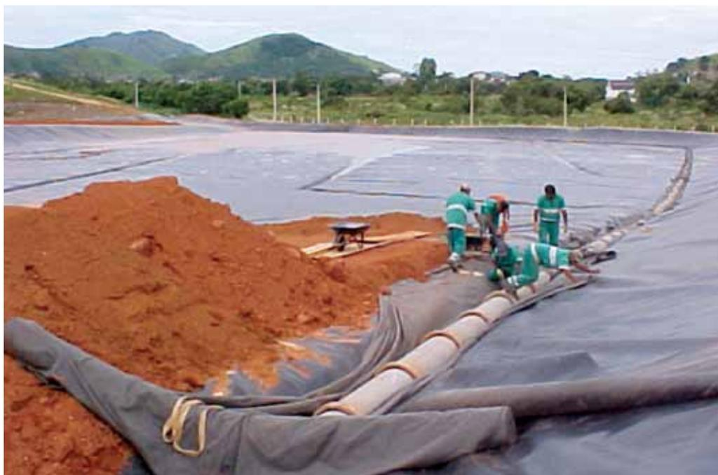
CTR de Gericinó – aplicação de manta e sistema de drenagem – ampliação do aterro
