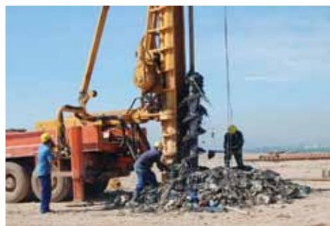
Perfuração de poço para captação de biogás do AMJG
