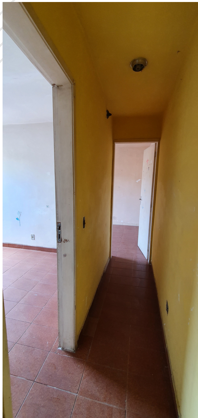
CORREDOR ACESSO AOS QUARTOS
