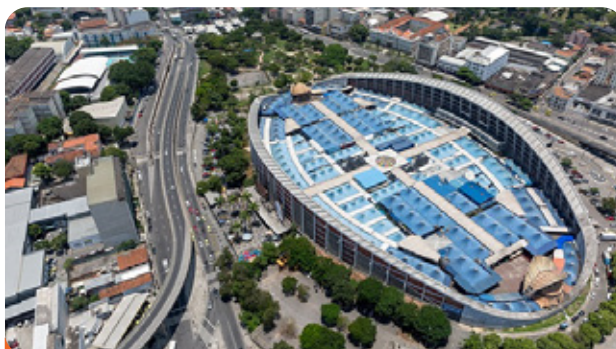
Imagem atual da Feira (Barracas dentro do pavilhão)
