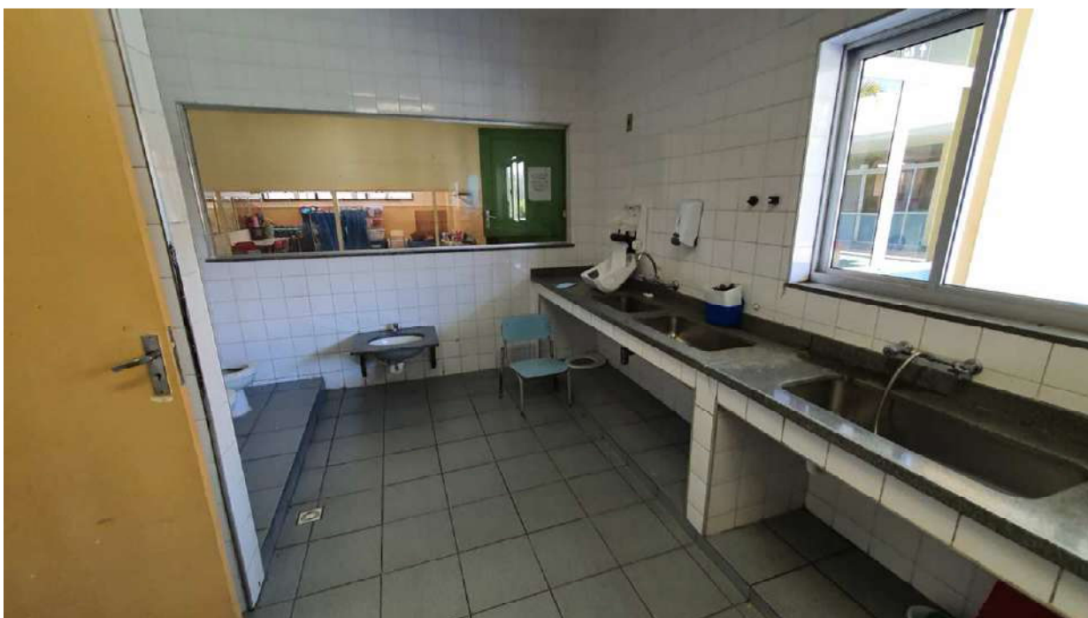
REVISÃO DAS BANCAS E LAVATÓRIOS COM TROCA DE CERÂMICAS COM FISSURAS NOS SANITÁRIOS INFANTIS
