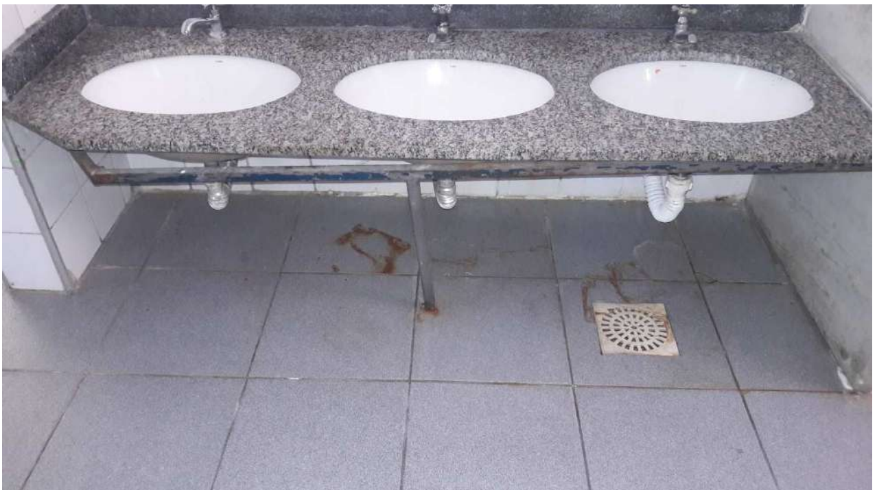
REVISÃO DOS LAVATÓRIOS INFANTIS COM SUBSTITUIÇÃO DO APOIO DE METAL
