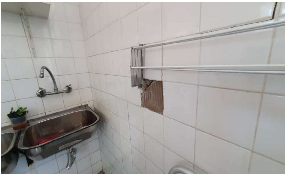
REVISÃO DO REVESTIMENTO DO SETOR DE COZINHA COM RECOMPOSIÇÃO DE PEÇAS CERÂMICAS E DO REJUNTE
