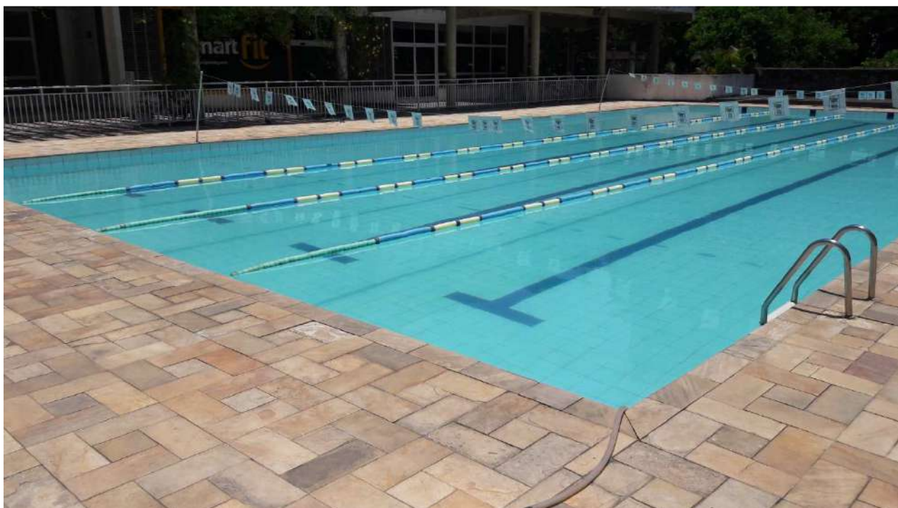
PISCINA SEMIOLÍMPICA; REVISÃO DOS REVESTIMENTOS
