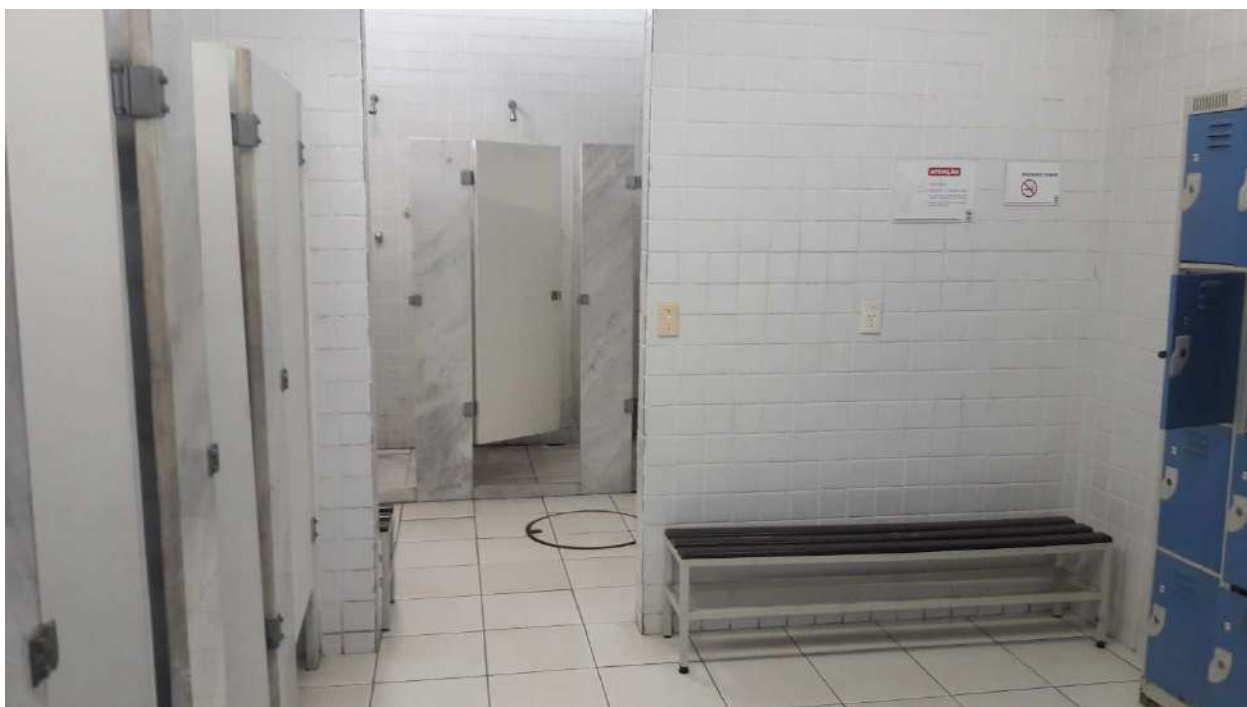
REVISÃO NAS INSTALAÇÕES HIDROSANITÁRIAS E DOS REVESTIMENTOS DOS VESTIÁRIOS
