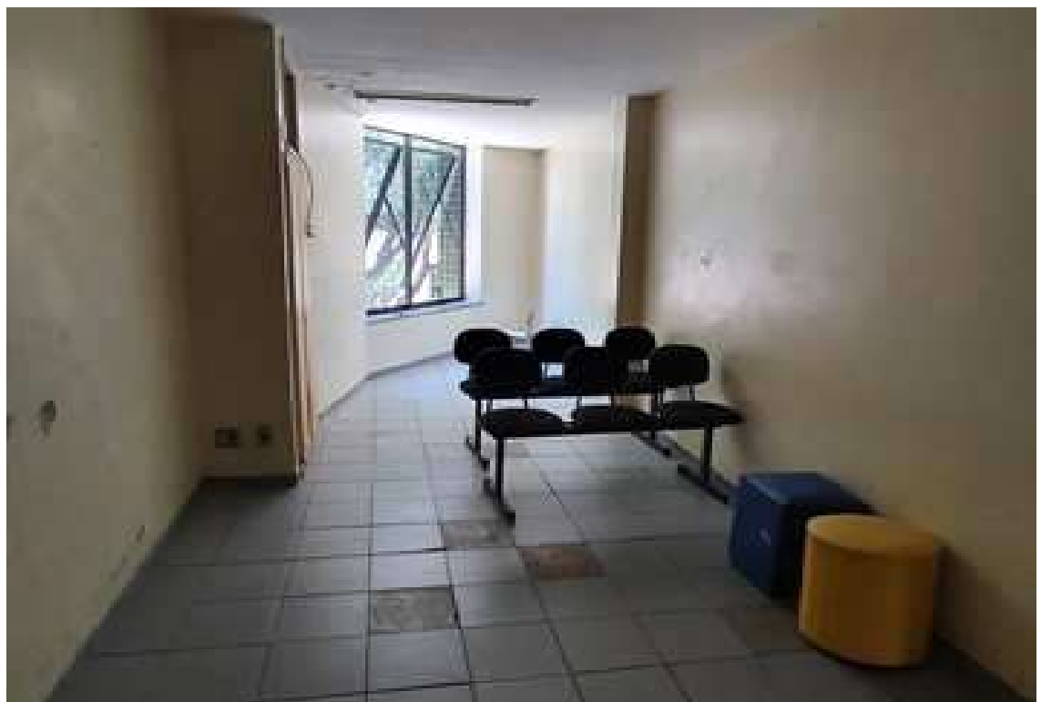
PISO CERÂMICO A SER RECOMPOSTO EM SALA DO PAVIMENTO SUPERIOR
