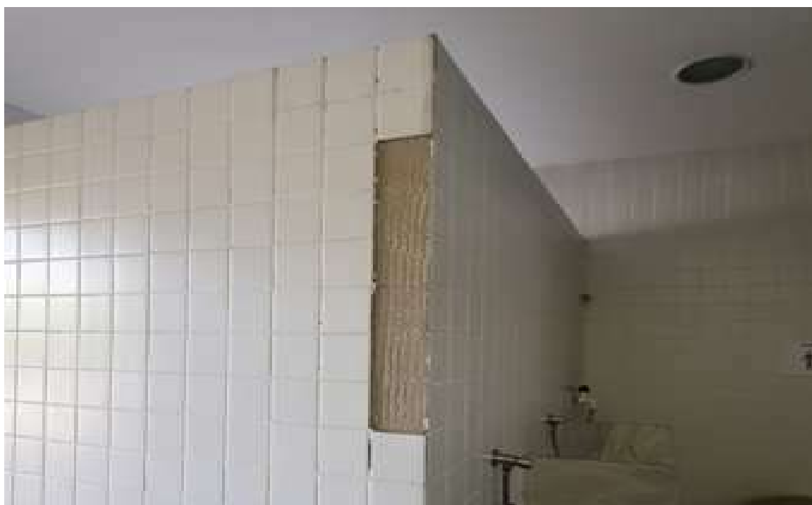
RECOMPOSIÇÃO DE PARTE DO REVESTIMENTOS DOS VESTIÁRIOS
