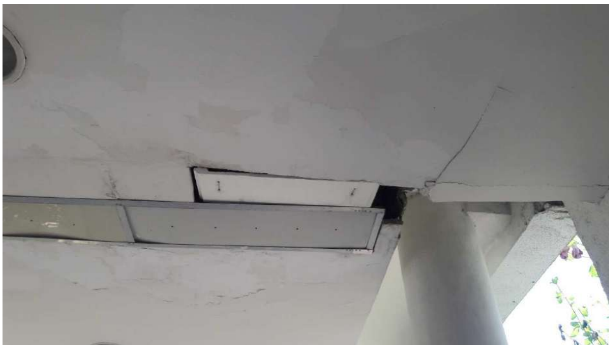
RECUPERAÇÃO DE JUNTA DE DILATAÇÃO ENTRE O PRÉDIO PRINCIPAL E O BLOCO DAS QUADRAS DE FUTEBOL E POLIVALENTE
