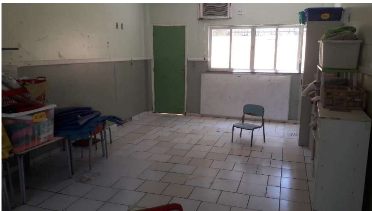
SALAS DE ATIVIDADES: RECOMPOSIÇÃO DE REVESIMENTOS E PINTURA. REVISÃO NOS PISOS E RECUPERAÇÃO DOS SEUS REJUNTES
