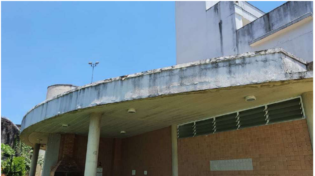
REVESTIMENTO INTERNO E CERÂMICO DAS CHURRASQUEIRAS A SEREM RECUPERADOS
