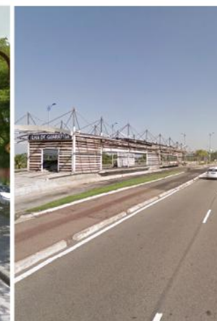
Etr. da Ilha - Estação BRT
