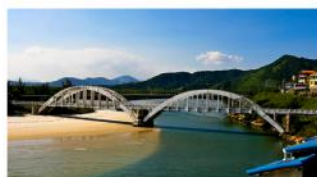
Ponte Eurico Gaspar Dutra - Acesso a Restinga da Marambaia
