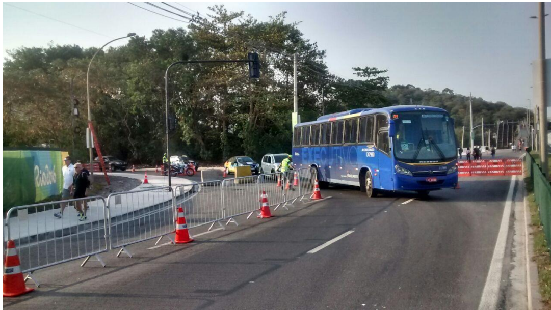
Figura 90: Avenida Salvador Allende compartilhada com pedestres
