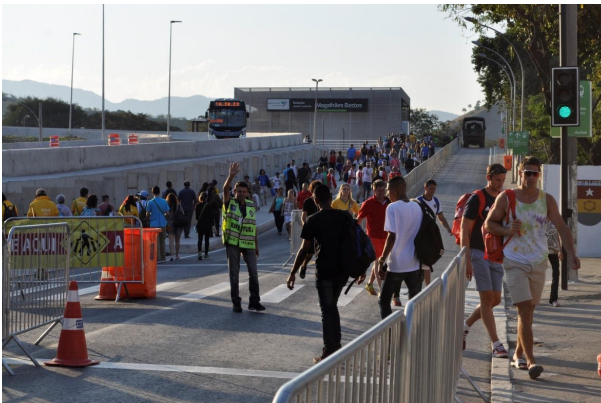
Figura 67: Viaduto de Magalhães Bastos para acumulação de pedestre
